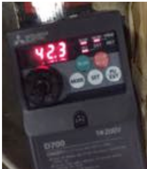
Gambar 10. Inverter (pengatur kecepatan motor)
